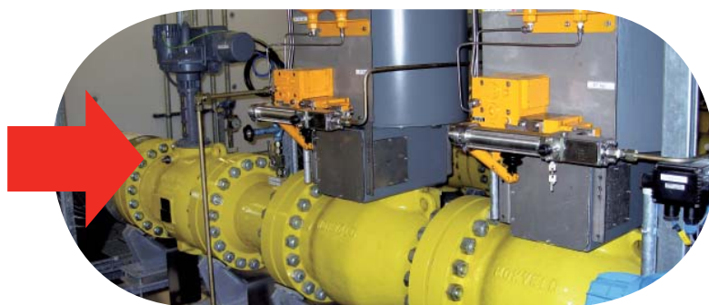
Системы HIPPS все чаще используются для защиты оборудования, персонала и окружающей среды.
